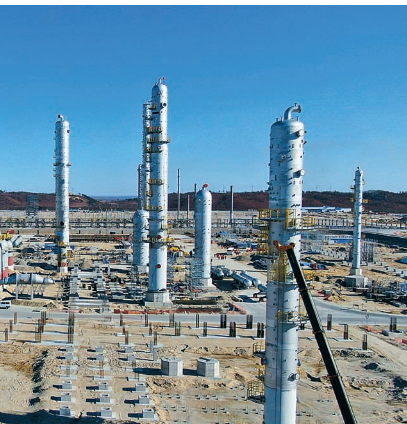
Амурский газохимический комплекс — совместный проект «Сибур» и китайской Sinopec. Запуск производства запланирован на 2024 год. По объемам производства АГХК превзойдет «Запсибнефтехим»
